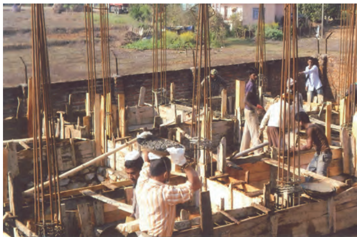
Escuela en construcción
